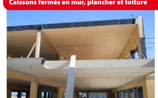
Caissons fermés en mur, plancher et toiture
